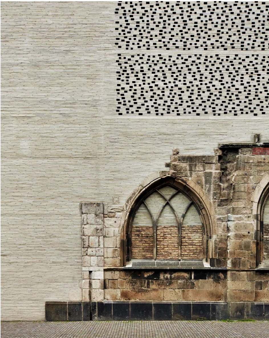
Figure 23 : Zumthor Peter – Kolumba Museum, Cologne, 2007 – Rapport briques / existant, – photographie: Anders Sune Berg
