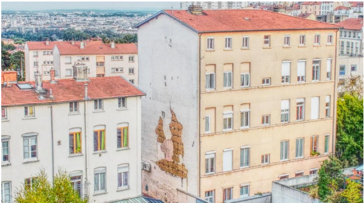
Figure 11 : Photo : Mur pignon d'un immeuble construit en pisé de terre, vers 1870 ,43 rue Coste à Caluire-et-Cuire, Plateau de la Croix-Rousse. Source : E. Mille, CRAterre-ENSAG, Le pisé en milieu urbain : l'exemple lyonnais, plateforme Satché.
