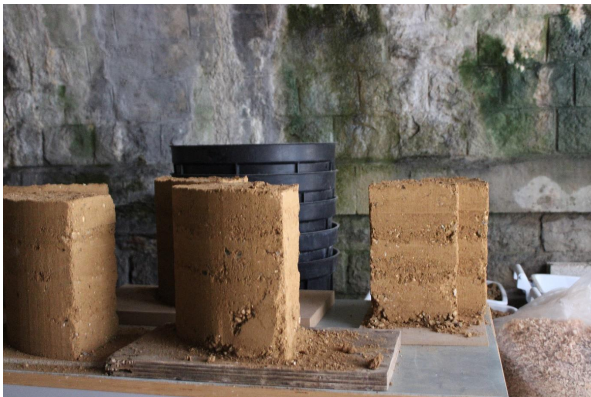
Figure 70 : Photo : Modules de pisé fraîchement démoulés mis en place dans la zone de séchage, où ils resteront trois à quatre semaines avant leur assemblage. Source : photo de l'autrice.
