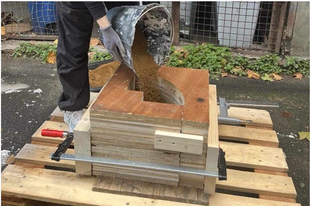
Figure 63 : Photo : Remplissage du moule en bois avec la terre préparée, disposée par couches avant tassage. L'installation, posée sur une palette et sur une planche en bois, permet de stabiliser le moule et de faciliter le déplacement des modules une fois compactés. Source : photo de l'autrice.
