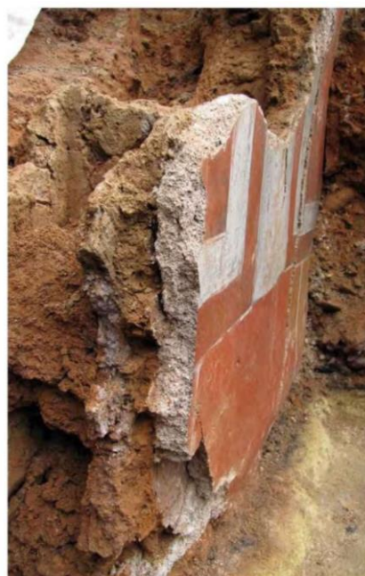
Figure 8 : Photo : Détail d'une cloison en terre couvert d'enduits décorés, Lyon, Clos de la Solitude. Source : Clément B. 2016, p. 41 4) .Source : E. Mille
