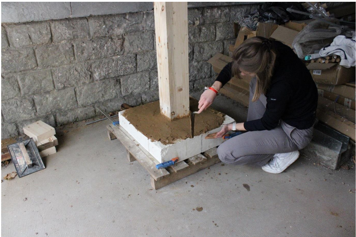
Figure 75 : Photo : Pose du poteau en bois sur la base en pierre, après application d'une couche de mortier de chaux et insertion sur le goujon d'ancrage inox M12 × 180 mm. Source : photo de l'autrice.
