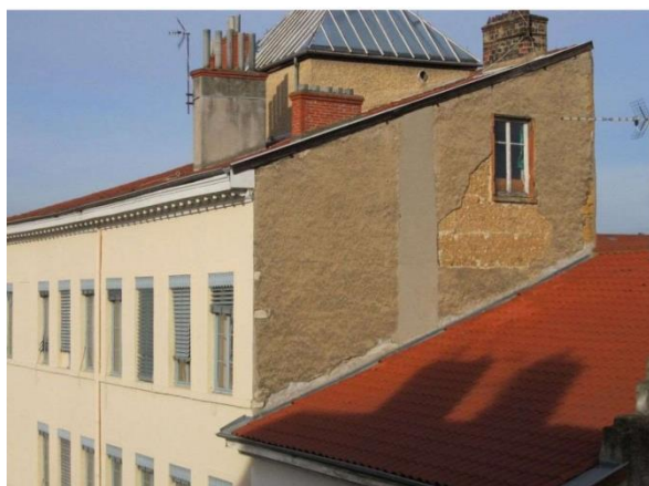
Figure 24 : Photo: Immeuble situé au 1, rue Pailleron (Lyon 4e, CL-201). Détail du pisé visible en pignon est. Source : Service des Balmes de la Ville de Lyon.
