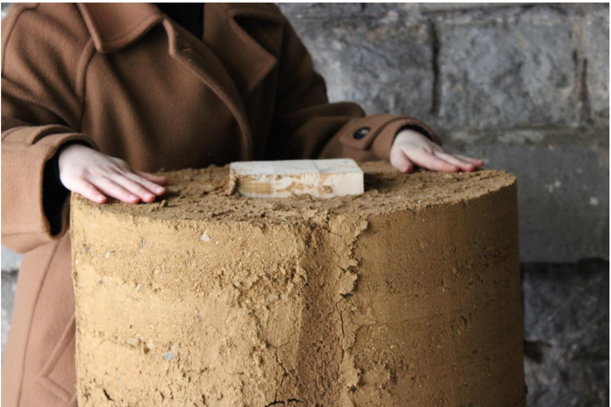
Figure 77 et 78 : Photos : Prototype final de la colonne en pisé. La première image montre la colonne entièrement montée autour du poteau en bois, tandis que la seconde illustre le sommet du prototype après lissage des joints et finition de la surface. Source : photos de l'auteur.
