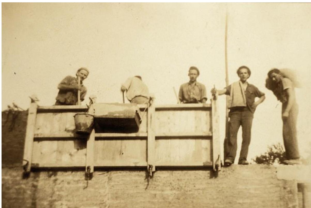
Figure 29 : Photo : Ouvriers en cours de montage d'un coffrage-banche pour pisé. Source : fonds « CRATerre/1261 »
