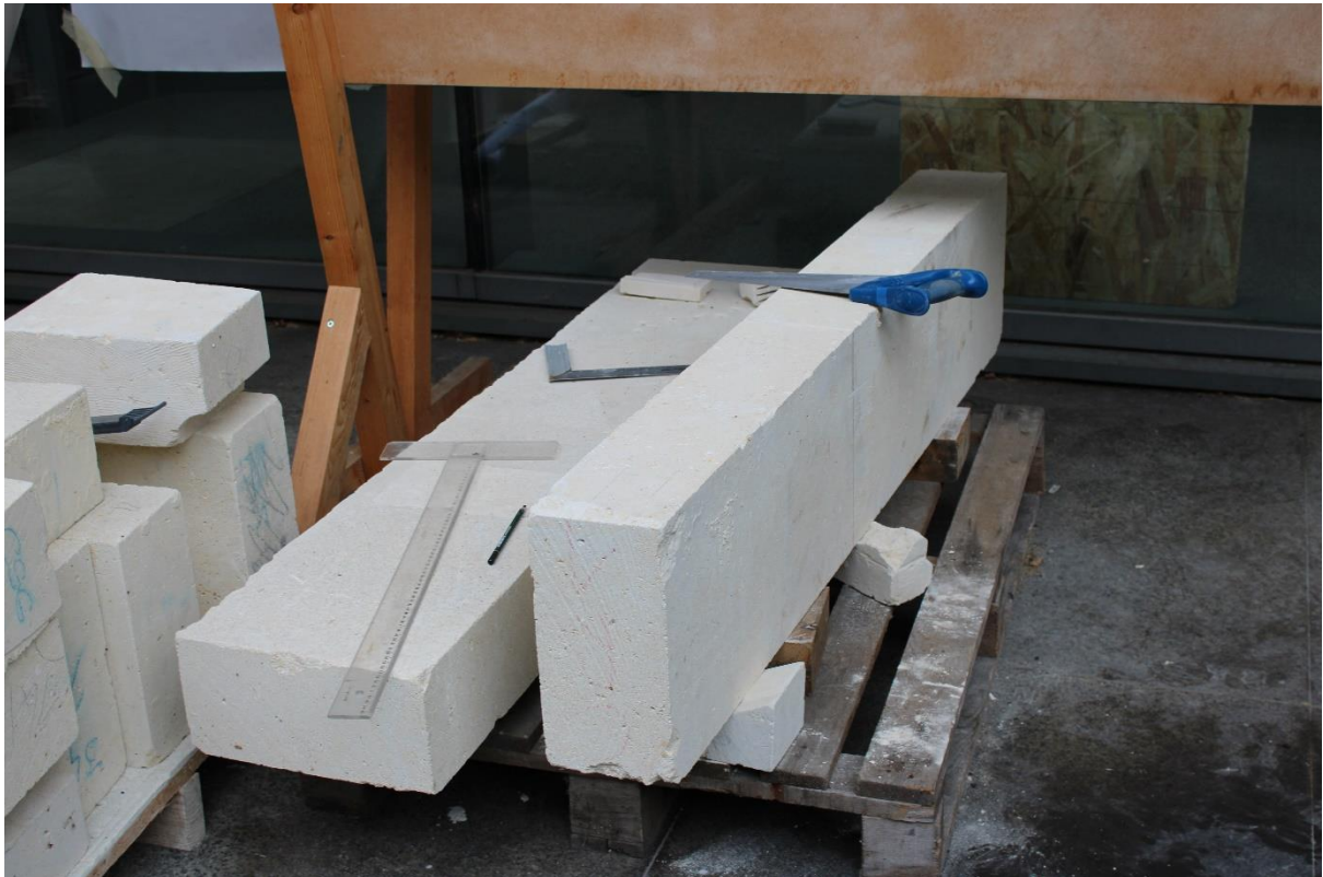
Figure 71 : Photo : Découpe du bloc de pierre calcaire destiné à former la base du prototype. Le grand bloc initial est tracé puis scié à la main pour obtenir les trois éléments nécessaires : un bloc central et deux blocs latéraux. Source : photo de l'autrice.
