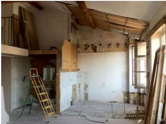
Figure 25 : Photo : L'intérieur de l'immeuble de trois étages situé au 12, rue Jacquard (Lyon 4 e ) lors des travaux menés en 2015 qui ont relevé la présence de pisé de terre dans les murs mitoyens perpendiculaires à la rue. Source : E. Mille
