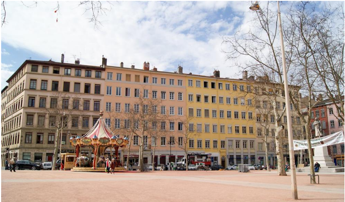
Figure 40 : Photo : Façades d'immeubles du XIX e siècle bordant la place de la Croix-Rousse (Lyon 4 e ), dont l'immeuble de six niveaux situé au n° 1. Ces bâtiments, aujourd'hui enduits et uniformisés, masquent souvent des structures anciennes en pisé caractéristiques du plateau comme les murs mitoyens, les pignons et certains refends intérieurs en pisé. Source : E. Mille.
