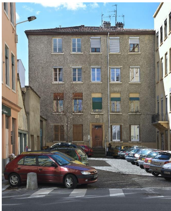
Figure 22 : Photo : Façade de l'immeuble-atelier du 27 impasse Gigodot (Lyon 4 e , Croix-Rousse), bâtiment en pisé enduit et remanié. Source : Inventaire général du patrimoine culturel, Région Auvergne-Rhône-Alpes, IVR82_20136901338NUCAQ.
