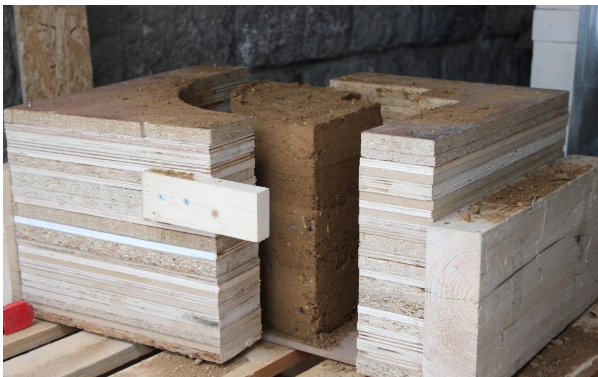
Figures 66 et 67 : Photos : Fin du compactage et démoulage du module de pisé du module de pisé. La première image montre moule maintenu par des serre-joints avant le démoulage. La seconde révèle le bloc de terre fraîchement extrait. La terre atteint ici la hauteur finale de 30 cm. Source : photo de l'autrice.
