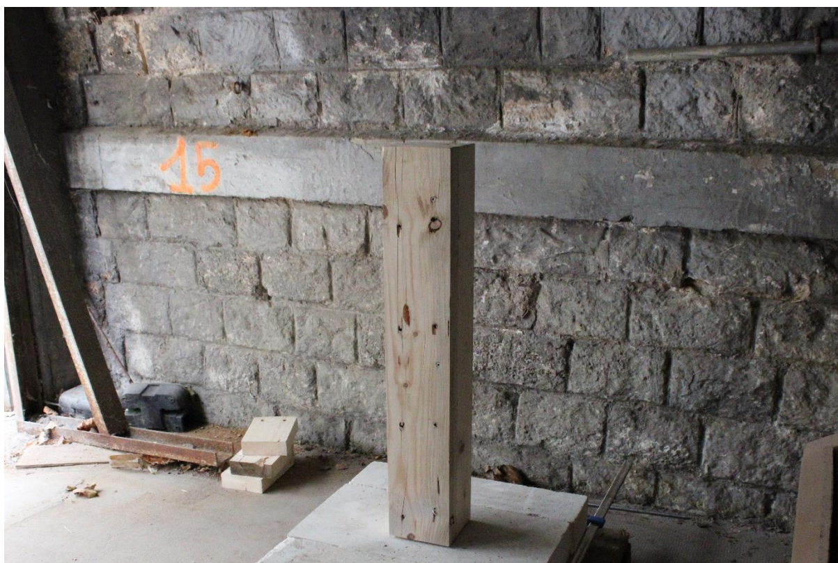
Figure 74 : Photo : Poteau en bois mis à dimension (14 × 14 cm) et découpé à 90 cm de hauteur, prêt à être fixé sur le goujon d'ancrage auparavant installé dans la base en pierre. Un trou de 12 mm est percé à sa base pour permettre l'emboîtement. Source : photo de l'autrice.
