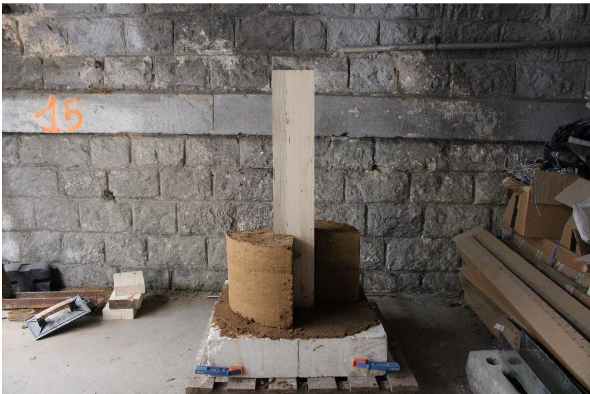
Figure 76 : Photo : Mise en place des modules en pisé autour du poteau. Source : photo de l'autrice.
