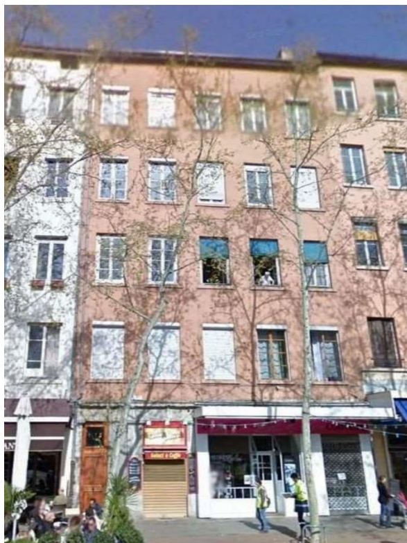
Figure 23 : Photo : Immeuble de cinq niveaux situé au 1, place des Tapis (Lyon 4e, CL-143). Source : vue Google.
